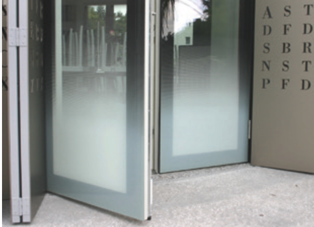
MIG für Nurglas-Optik mit Punktverlaufsrastrer zur Teilmaskierung
