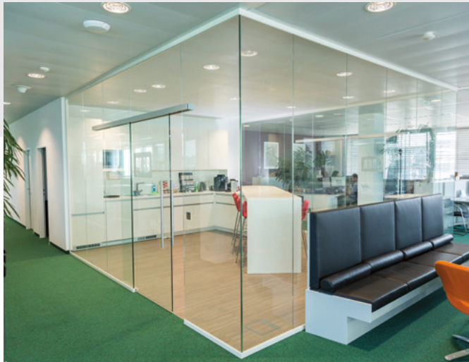
Raumtrennwand mit Durchblick aus ESG
