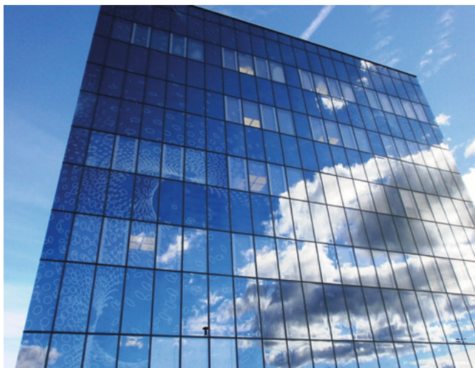
Vorgehängte Glasfassade aus ESG-HST mit Designdruck
