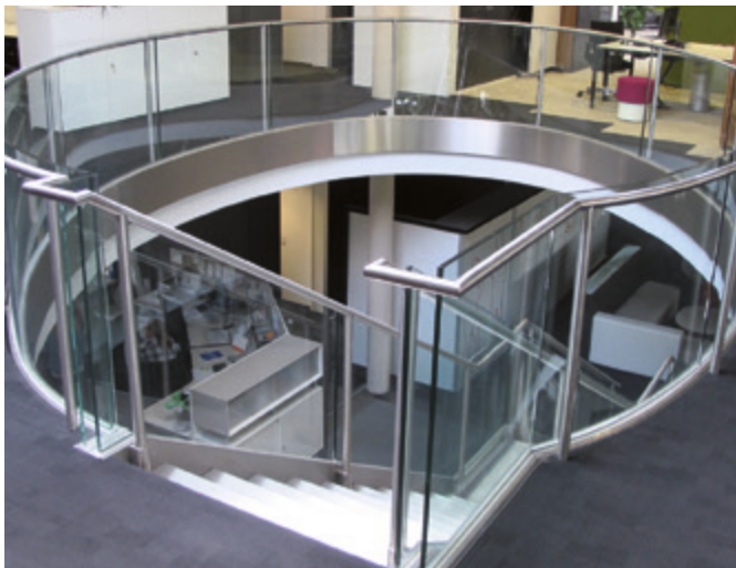
Einseitig eingespannte Glasbrüstung
