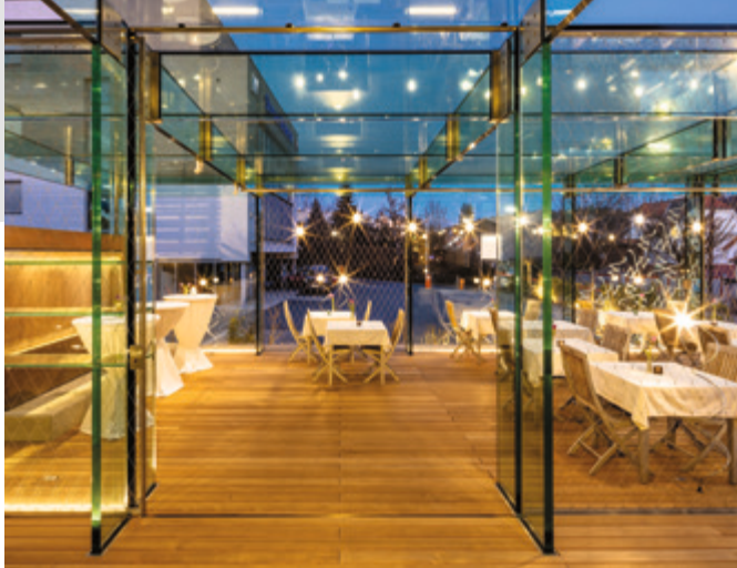
Glasbalken für tragende Funktion
